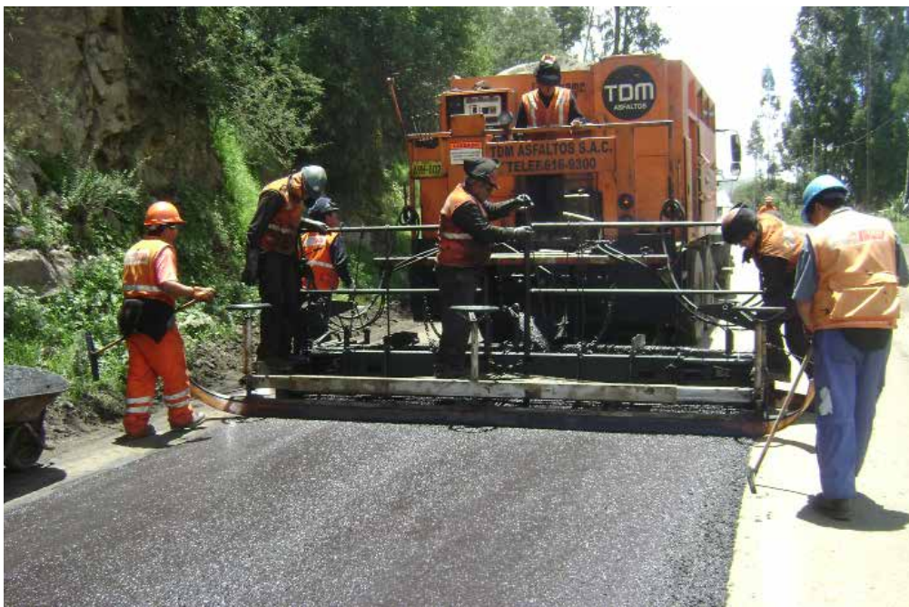
► Slurry Seal
