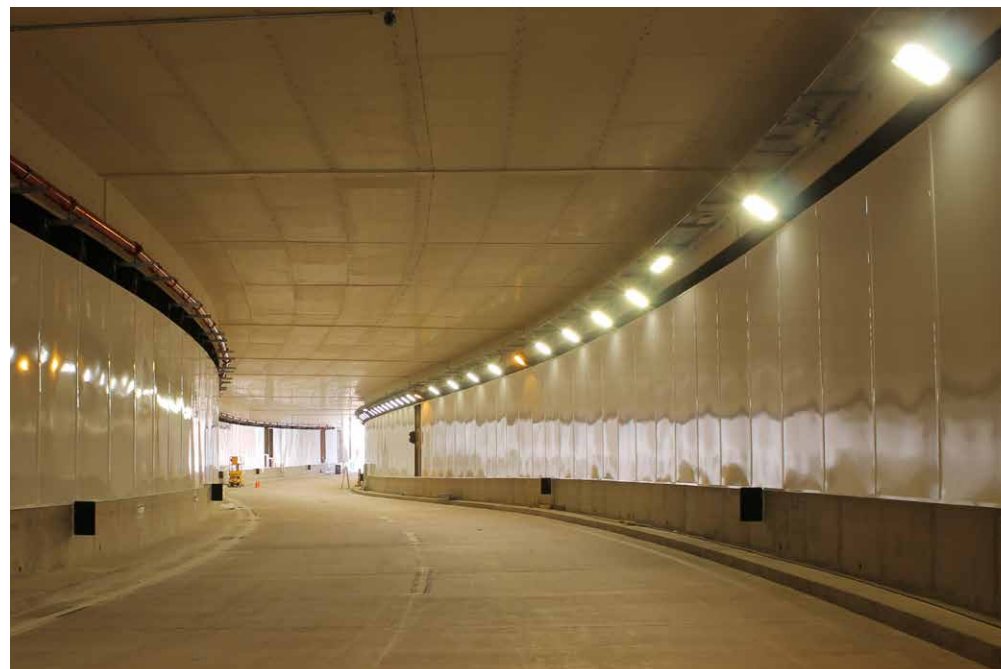
► Tunnel cladding
