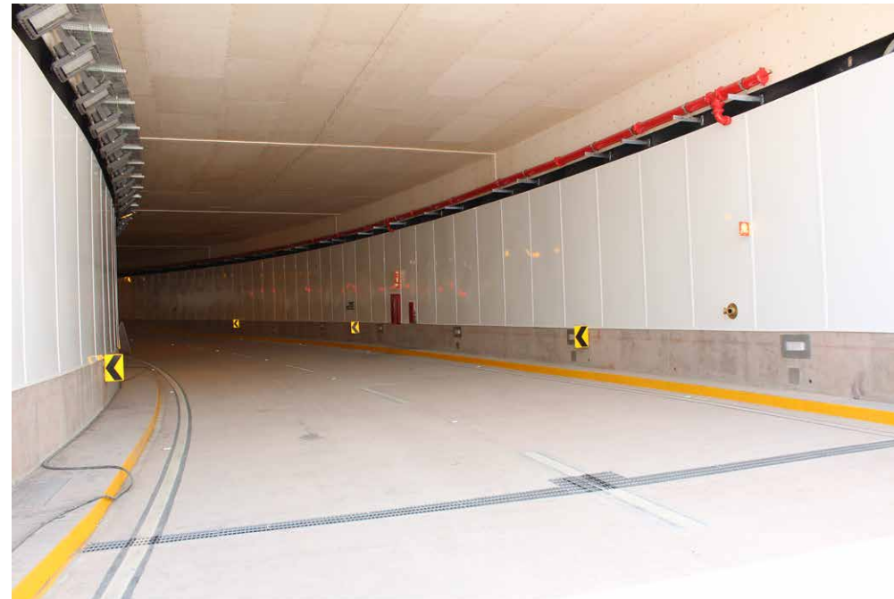
► Tunnel cladding
