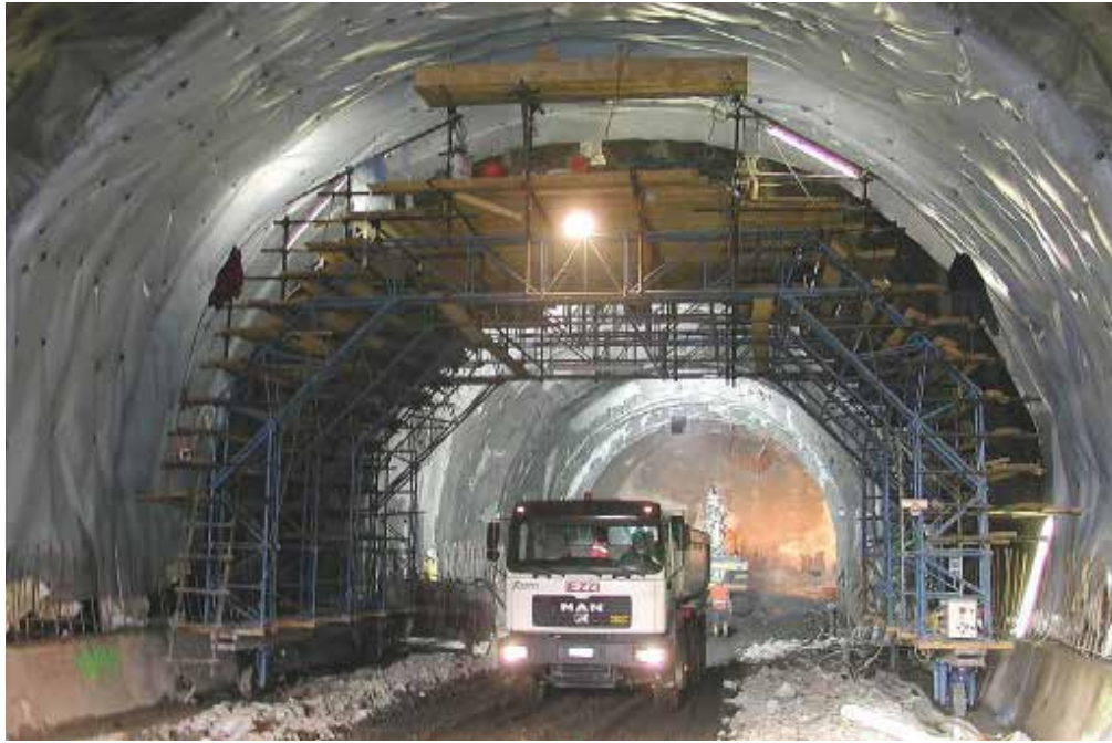
► Tunnel waterproofing
