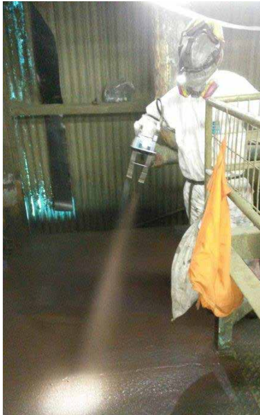
► Liquid waterproofing
