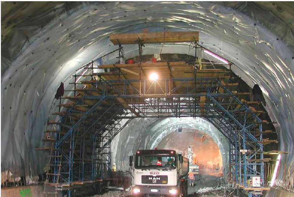
► Tunnel waterproofing
